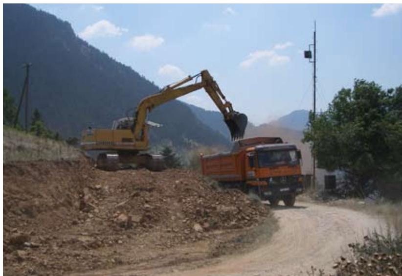
Εντατικές εργασίες στο δρόμο Νεραΐδα - Τριφύλλα
