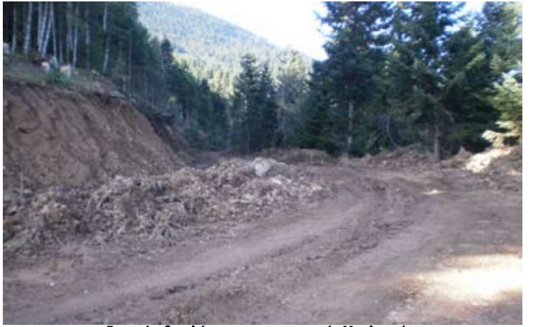
Έργασιες διαπλάτυνσης στην περιοχή «Μουλαημέρ»
