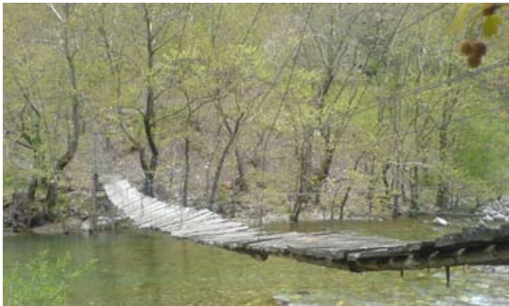
Το γεφύρι στο Μπεσιώτη πριν την καταστροφή
