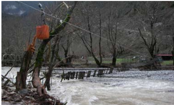
Το γεφύρι στο Μπεσιώτη μετά την καταστροφή
