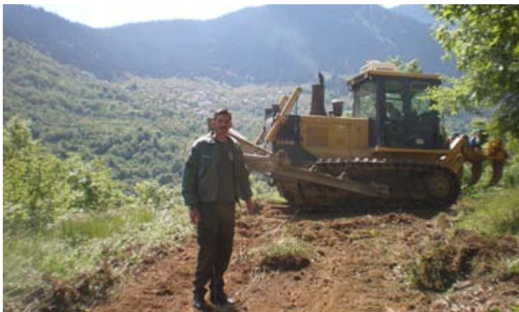
Έτσι φαίνεται η Νεράϊδα απ' τα Κουκείικα. Σε πρώτο πλάνο η μπουλντόζα ενώ δουλεύει ανοίγοντας το δρόμο και αποκαθιστώντας την συντομότερη σύνδεση μεταξύ Νεραϊδας και Καροπλεσίου δια μέσω Σωτήρας – Κουκείικα.
