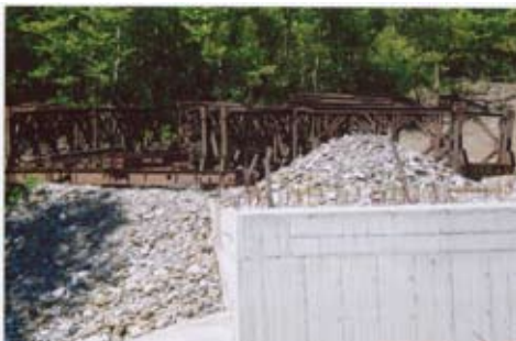
Τα βάθρα περιμένουν τη γέφυρα που υπάρχει δίπλα
