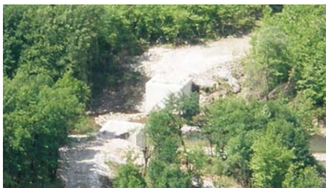
Τα τσιμεντένια βάθρα περιμένουν ακόμα να στηθεί πάνω τους η γέφυρα.
