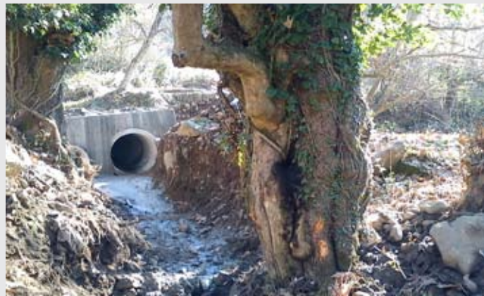
Η 2η φωτό που μας έστειλε ο Πρόεδρος όπου φαίνεται καθαρά η δεύτερη μεγαλύτερης διαμέτρου σωλήνα που μπήκε στο τεχνικό.
