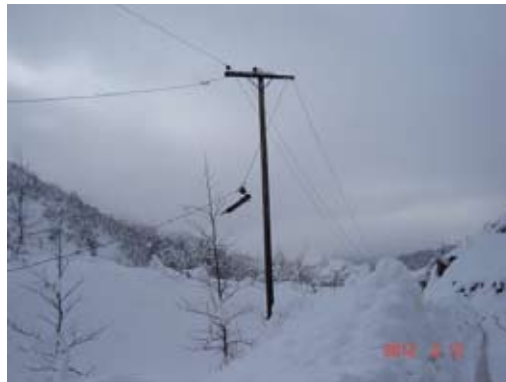
Παντού έβλεπες σύρματα κομμένα, τραβέρσες σπασμένες και τα κομμάτια τους μαζί με τους μονωτήρες να αιωρούνται με τα κομμένα σύρματα.
