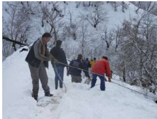
Συνεργείο τεχνικών της ΔΕΗ απλώνει καινούργια σύρματα στην κατεστραμμένη γραμμή μας.
