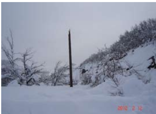
Κολόνα σπασμένη «σαν πράσο» στη μέση! Όπου άντεχαν τα «σαν βαρέλια πετρελαίου» φορτωμένα με χιόνι σύρματα και δεν κόβονταν, έσπασαν τις κολόνες στη μέση με το τεράστιο βάρος τους.
