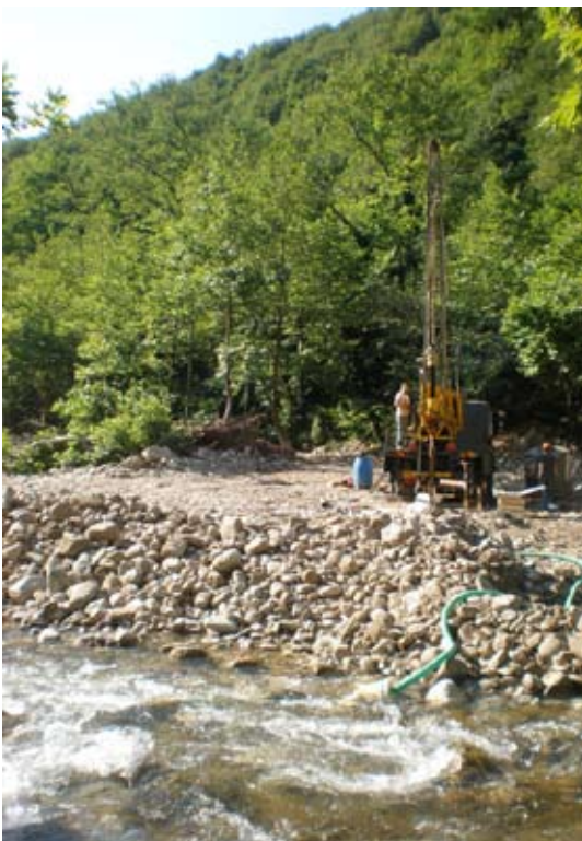
Το γεωτρύπανο που έκανε τις γεωτρήσεις στη θέση «Ζάχνας» στις αρχές Ιουλίου 2012.
