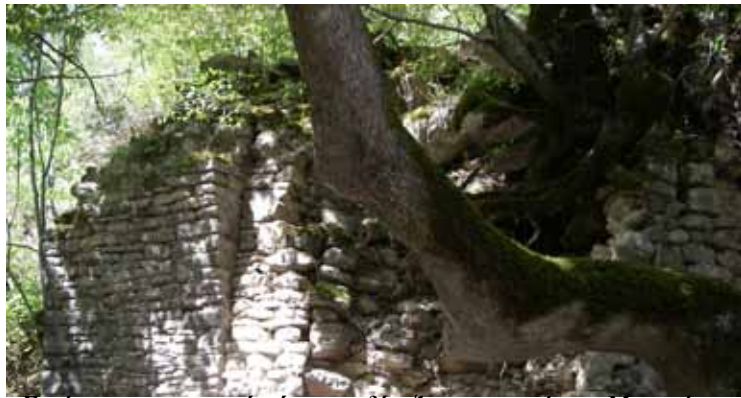
Ερείπια μεσαιωνικού πέτρινου δίοξου γεφυριού στο Μπεσιώτη, λίγο πιο πάνω από τη σμίξη του με το Μέγδοβα. (Φωτ. Αρχ. Γιάννη Μαλιτή)
