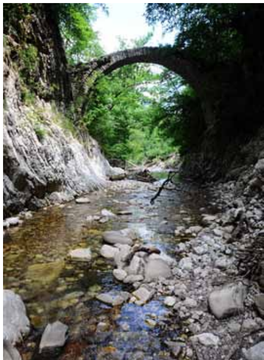
Το πέτρινο τοξωτό γεφύρι στο Μπεσιώτη όπως το βλέπουμε όταν κατεβαίνουμε το ποτάμι.
