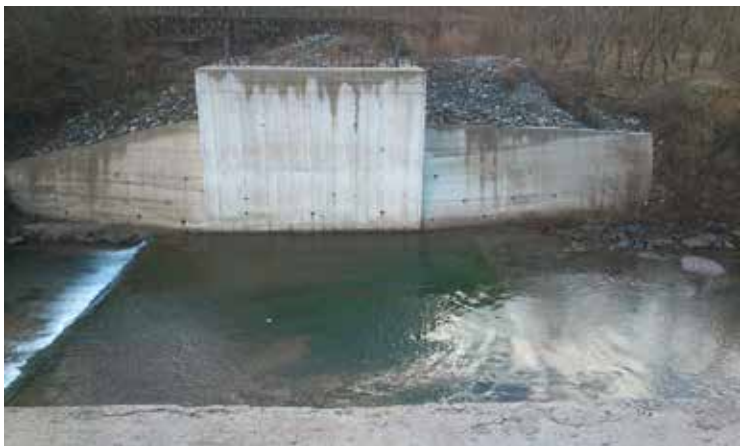
Τα τσιμεντένια βάθρα περιμένουν τη γέφυρα στα «Ρογκάκια»... Πότε επιτέλους θα στηθεί; Τι ενέργειες έχουν κάνει ήδη οι αρμόδιοι;
