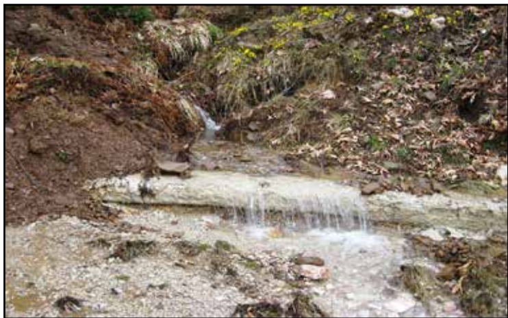
Τεχνικό βουλωμένο στο δρόμο Νεράϊδα – Τριφύλλα και το ρέμα τρέχει μέσα στο οδόστρωμα καταστρέφοντάς το. Πότε θα το ξεβουλώσουν οι αρμόδιοι;
