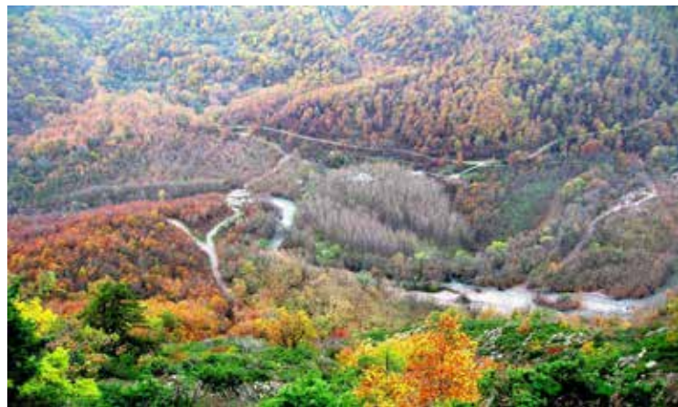
Η θέση του «υπό κατασκευήν» γεφυριού «Ρογκάκια» στο δρόμο που ενώνει τη Νεράϊδα με το Καροπλέσι. Εδώ όπως φαίνεται από μακριά.
