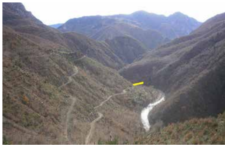
Η θέση «Ζάχενας» όπου θα γίνει η Γέφυρα Μέγδοβα της οποίας οι μελέτες ολοκληρώθηκαν... και ζητείται πρόγραμμα χρηματοδότησης για την δημοπράτησή της... (Η φωτό από την ιστοσελίδα μας «neraida-dolopwn.com» / Φωτογραφίες / Φάκελος 5 / αυξ. αριθ. 26 από 82).
