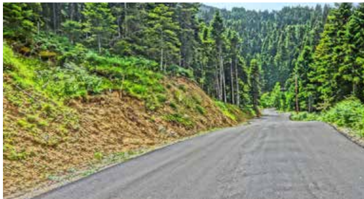
Οδικός άξονας Καρπενησίου – Λίμνης Πλαστήρα... τμήμα Νεράϊδα – Τριφύλλα... κομμάτι «Σπίτι Διαβάτη» – «Πλατανόρεμα»... ασφαλτοστρωμένο πλέον από την Πέμπτη 26.5.16... εδώ στη θέση «Πλατανόρεμα»... (την φωτό μας έδωσε ο αγαπητός μας Βασίλης Θάνος εκ Σαρανταπόρου).
