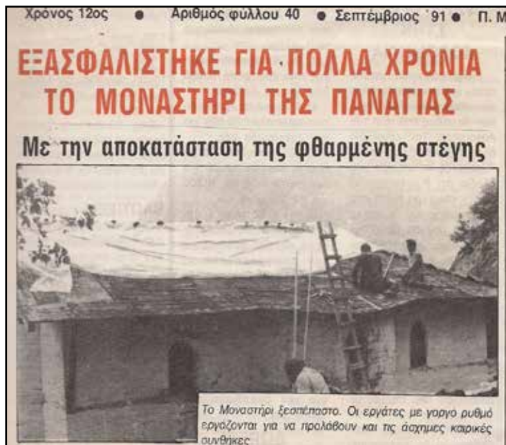
Ιερός Ναός Γεννήσεως Θεοτόκου Σπινάσας (Νεράϊδας) τον ομώνυμο Μοναστηριό μας, το καλοκαίρι του 1991... κατά τη διάρκεια εργασιών αλλαγής της στέγης και των κεραμιδιών... (Η φωτο είναι στην πρώτη σελίδα, του 40 φύλλον, της Εφημερίδας μας «Τα Χρονικά της Νεράϊδας – Δολόπων», του Σεπτεμβρίου 1991 - σίγουρα την έβγαλε ο αείμνηστος Δάσκαλος Κώστας Ι. Ζήσης). (Φωτό 85 από 93).
