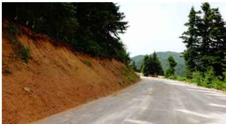
Οδικός άξονας Καρπενησίου – Λίμνης Πλαστήρα... τμήμα Νεράϊδα – Τριφύλλα... κομμάτι Νεράϊδα – Πλατανόρεμα... θέση «Δραμπάλα»... έτοιμο για ασφαλτό... (την φωτό μας έδωσε ο αγαπητός μας Βασίλης Θάνος εκ Σαρανταπόρου).
