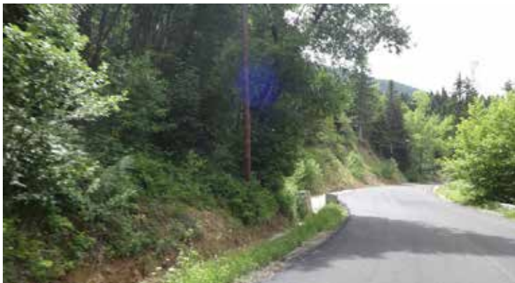
Οδικός άξονας Καρπενησίου – Λίμνης Πλαστήρα... τμήμα Νεράϊδα – Τριφύλλα... κομμάτι «Σπίτι Διαβάτη» – «Πλατανόρεμα»... ασφαλτοστρωμένο πλέον από την Πέμπτη 26.5.16... εδώ στη θέση «Μουλαημέρ»... (την φωτό μας έδωσε ο αγαπητός μας Βασίλης Θάνος εκ Σαρανταπόρου).
