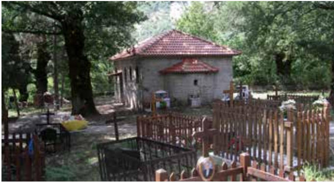
Ο Ι. Ν. Αγ. Ταξιάρχων Νεράϊδας όπως είναι σήμερα μετά την ανακαίνιση.
