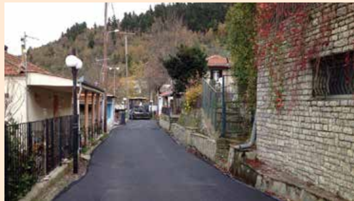
Κεντρικός δρόμος Νεράϊδας... από το κομμάτι που στρώθηκε...
