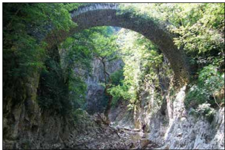
Το μεσαιωνικό πέτρινο τοξωτό γεφύρι στο Μπεσιώτη.
